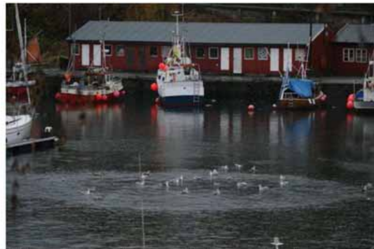
Bildet over illustrerer ulempene ved fellessystemet. Her slippes fortynnet avlopsvann ut i Vågen på grunn av kraftig nedbor. (Foto: www.brunsvika.net )
